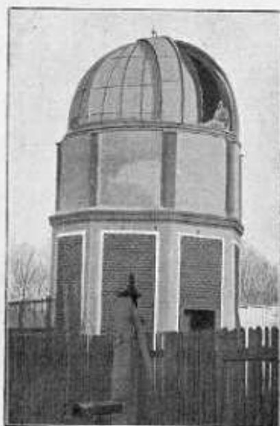
5 m-Kuppel, eig. Konstr., der böhm. Universitäts-Sternwarte Prag (vorm. Herrn Pastor Brödel in Stätzsch gehörig),
