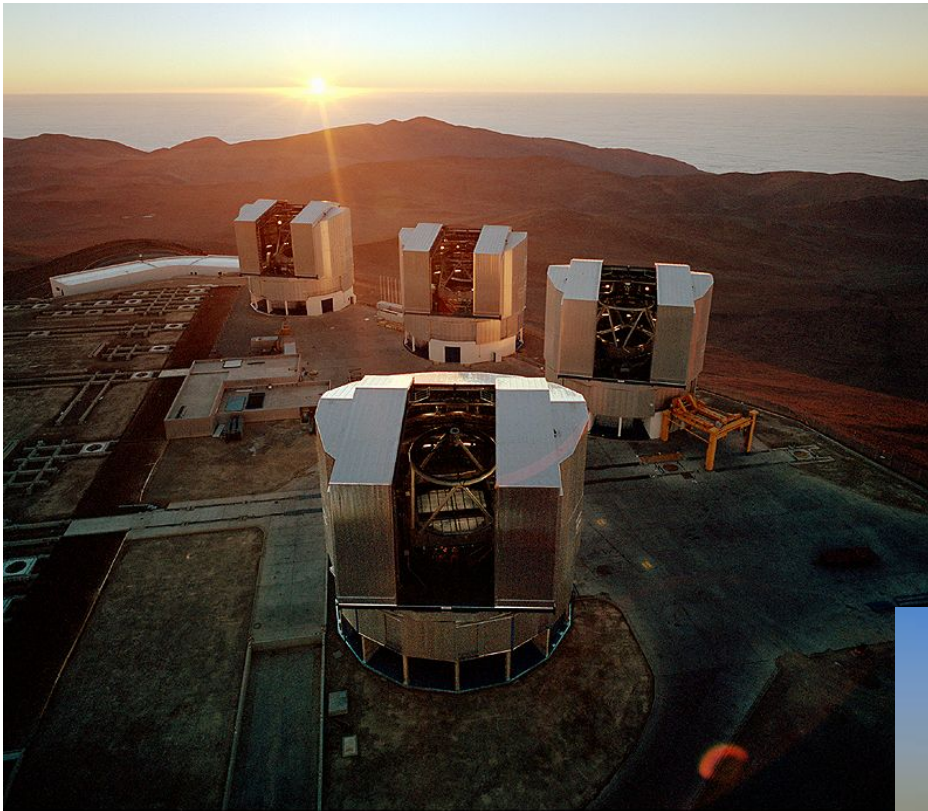
European Southern Observatory, Cile. Very Large Telescope , 4 telescopii riflettori da 8 m di diametro.
